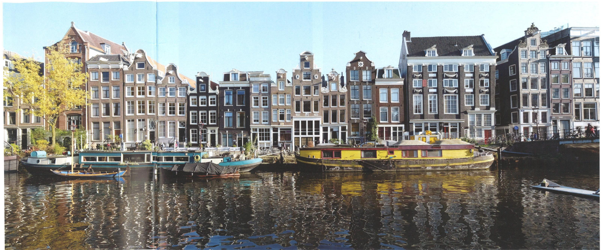
Afb. 1 Grachtenpanden hebben sterk geperforeerde gevels en zijn volgens de gemeente zijdelings instabiel (foto: auteurs)
