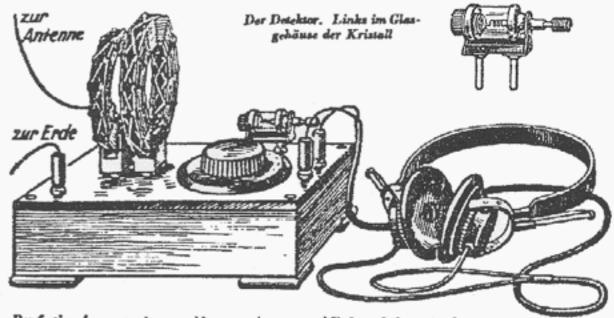
Der fertige Apparat mit angeschlessener Antenne und Erde und eingestöpseltem Kopf hörer
